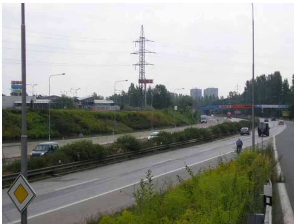
Obr. 2.1.12 Rychlostní městská komunikace (Ostrava-Zábřeh, ulice Rudná – u Shopping Parku).
