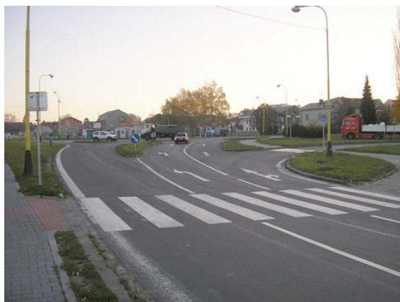
Obr. 2.1.21 Příklad usměrněné úrovnňové křižovatky (Hlučín, křižovatka Opavská-Ostravská-Celní); na fotografii jsou patrné fyzické směrové ostrůvky.
