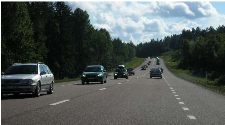
Obr. 2.1.5 Silnice v extravilánu – dvoupruhová (Švédsko); s rozšířenou krajnicí usnadňující předjíždění.
