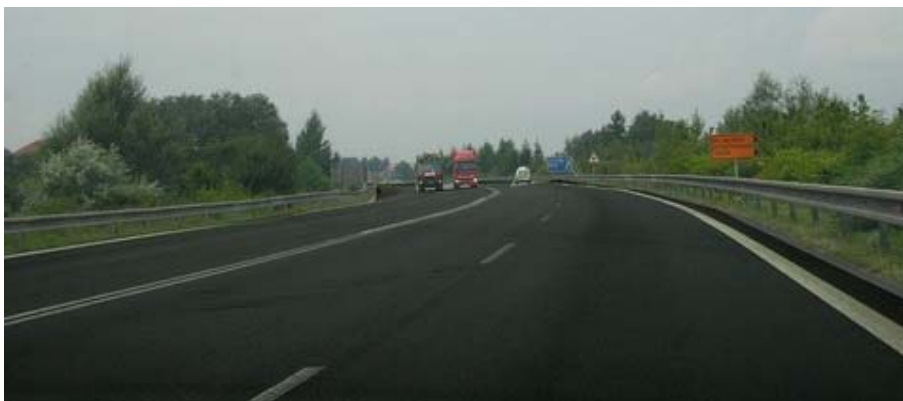
Obr. 2.1.6 Silnice v extravilánu – čtyřpruhová směrově nerozdělená (silnice č. I/48 z Frýdku-Místku do Příboru; před Příborem).
