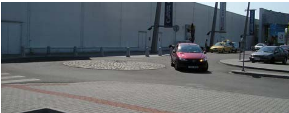
Obr. 2.1.27 Mini okružní křižovatka (na tomto příkladu z Karviné, u Hypernovy, je vidět chybná jízda osobního automobilu).
