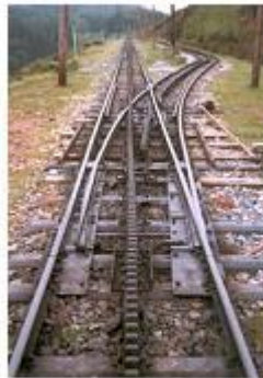
Kolej a výhybka s ozubnicí.
